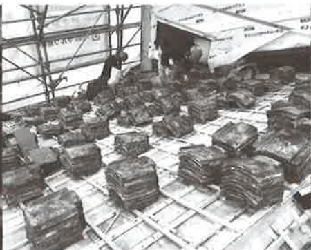
▲屋根瓦の葺き替え作業
